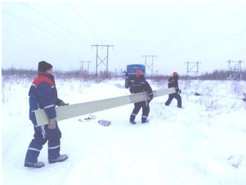
Рис.5. Доставка траверсы к месту монтажа.
