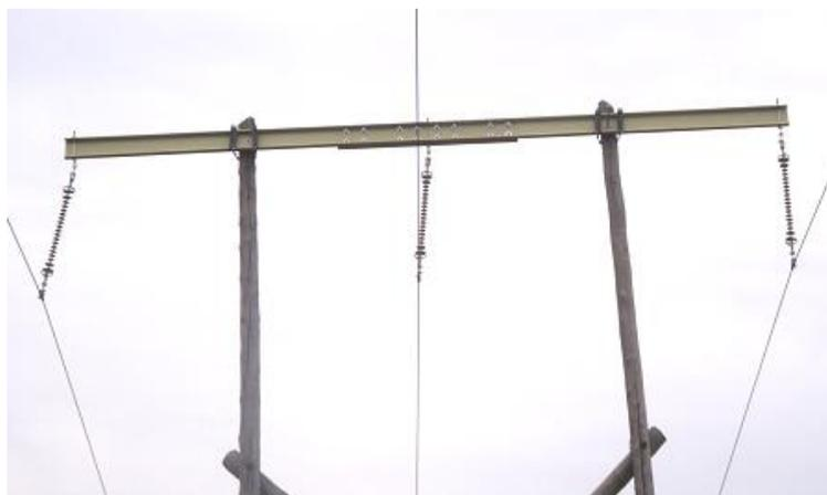
Рис.6. Опытная траверса на опоре ЛЭП 110кВ.
